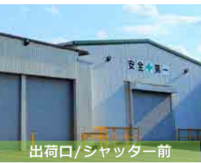
出荷口/シャッター前
