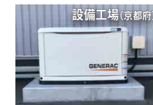
機種：ガーディアン 型番：G614 燃料：LPガス 用途：BCP対策 補助金：石油災害ハルク等の導入事業費補助金
